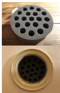
吸音材を吸気口に 設置した様子
